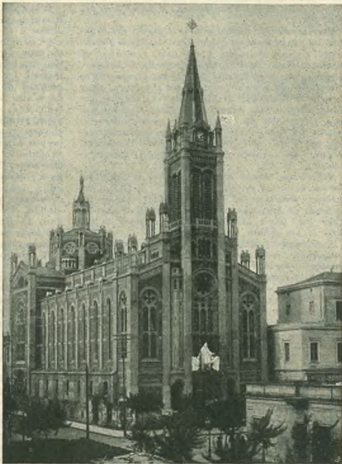
BUENOS AIRES (Almagro) — Il nuovo tempio in costruzione.
